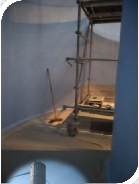
Réservoir de Charly sur Marne (La Nouette)
