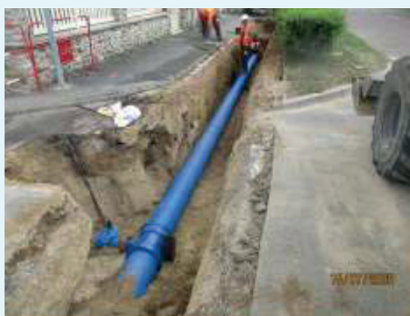
Travaux réalisés avenue de Montmirail Canalisations renouvelées : • 810 ml en DN 300 Fonte 38 branchements renouvelés
