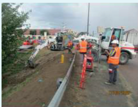
Travaux réalisés avenue E. Couvrecelle Canalisations renouvelées : • 75 ml en DN 250 Fonte 4 branchements renouvelés
