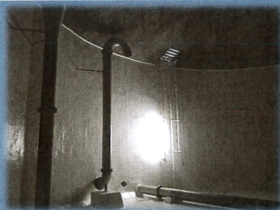
Réservoir d'Etampes sur Marne
